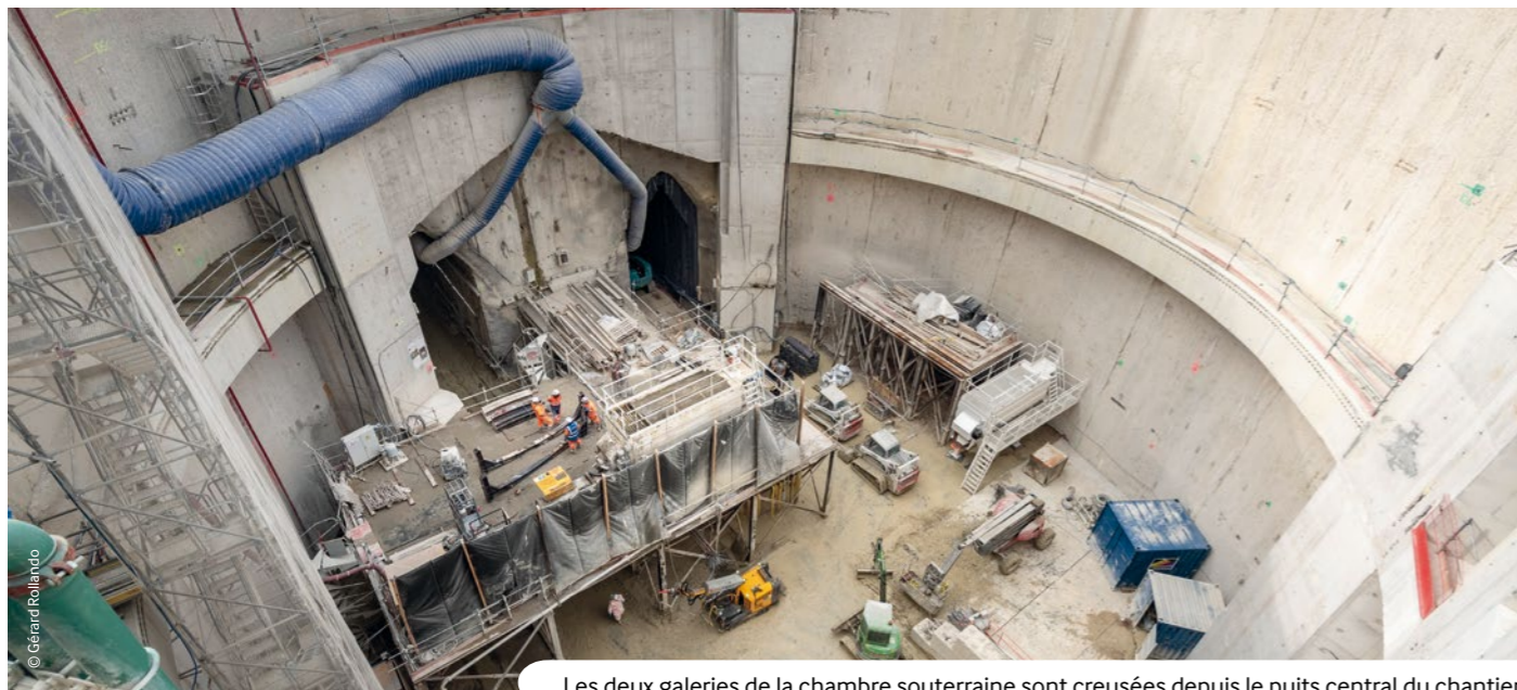
Les deux galeries de la chambre souterraine sont creusées depuis le puits central du chantier.
